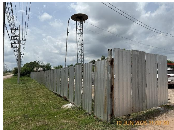
รูปถ่ายที่ 3.2-16 : กำแพงกันเสียงตามแนวเขตพื้นที่ก่อสร้าง
